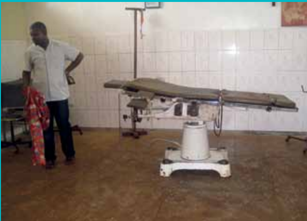
De vloer en de muren van de operatiezaal werden hersteld. Inmiddels is ook de operatietafel aan vervanging toe.
