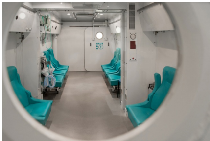
Zijaanzicht van de drukkamer en het sas.
